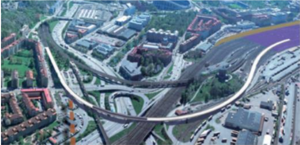
Fig: Nordlig viadukt vid Skansen Lejonet /12/
